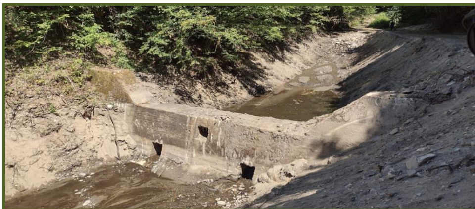
Slika 21. Očišćena predbrana na Crcavačkom potoku, 2022. godina (foto S. Simić)
