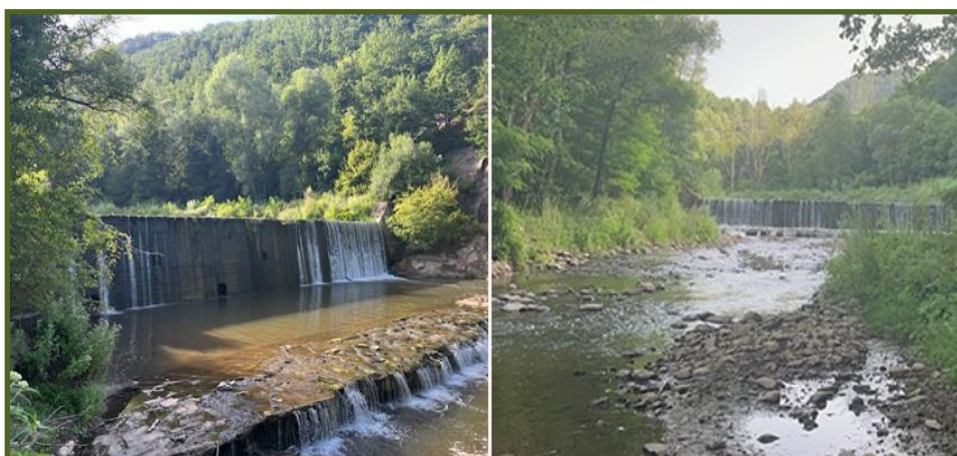
Slika 22. Zapunjene predbrane na reci Veternici, avgust 2023. godine (foto M. Simić Savić)
