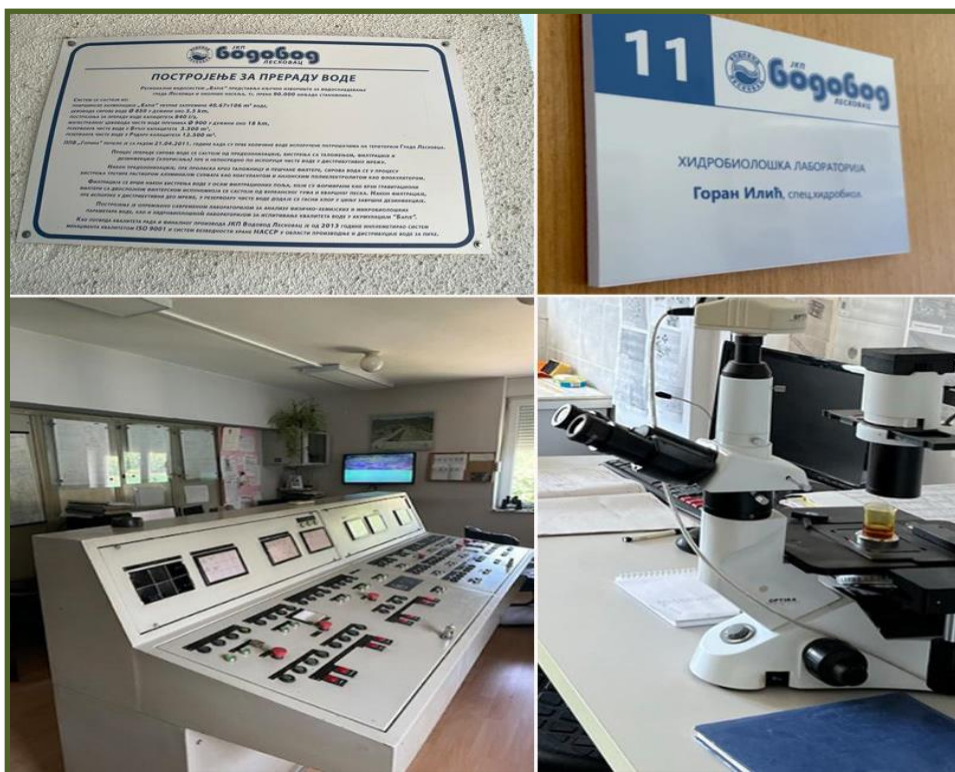
Slika 19. Postrojenje za prečišćavanje vode „Gorina“ (foto M. Simić Savić)
